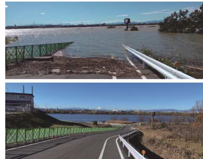
令和元年台風第19号で水没した道満グリーンパークと復旧後の様子
